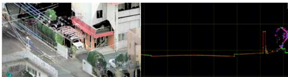
(株) 水上洋行本社社屋 3Dレーザースキャナ計測により断面を自動抽出
